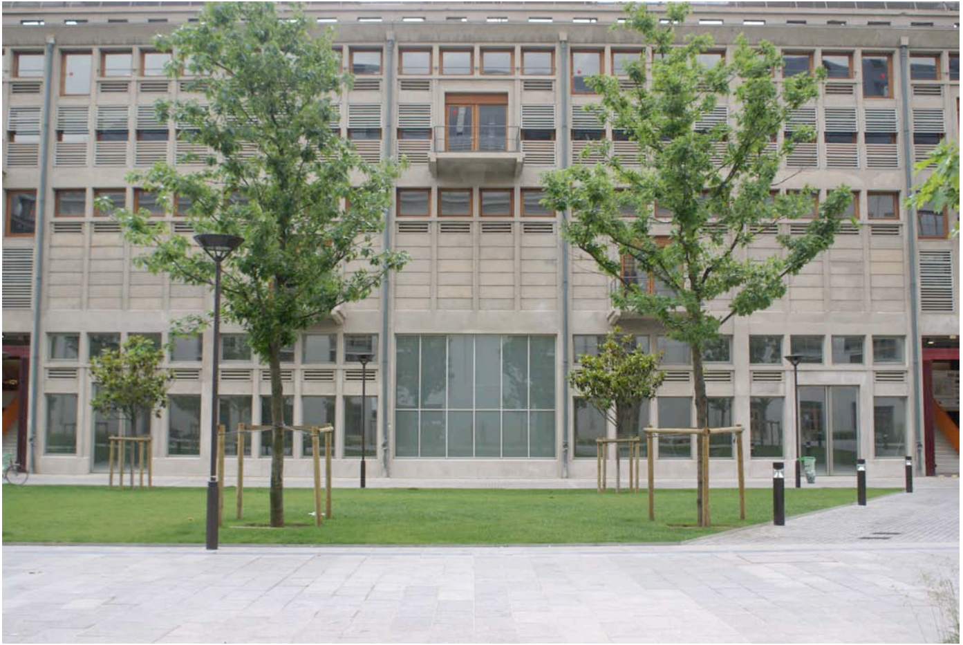
Vue de la façade de Bétonsalon
